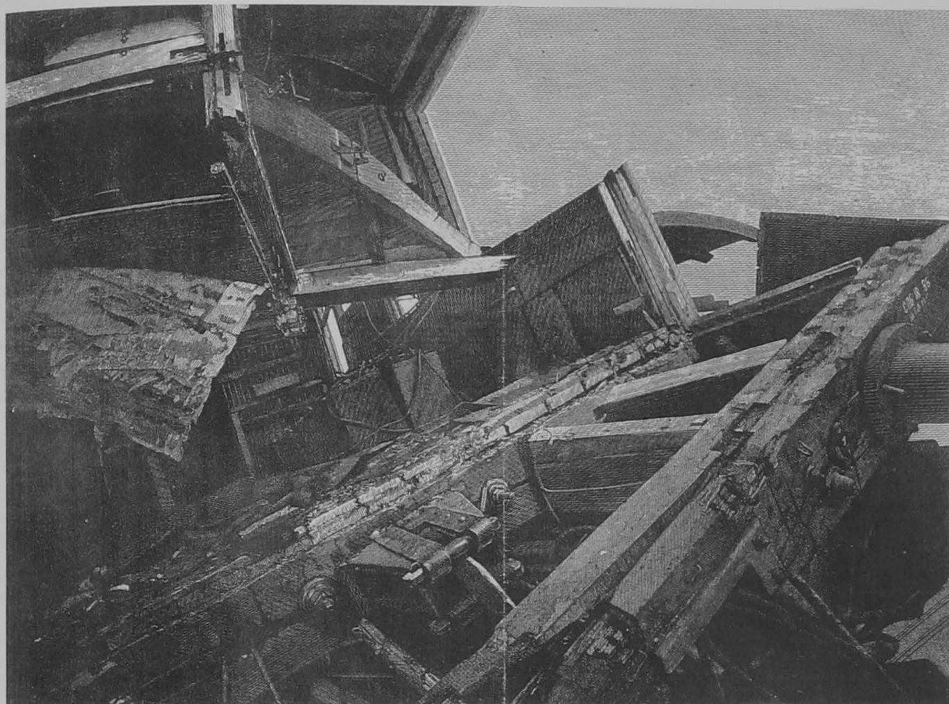
13. Железнодорожная катастрофа под Борками. Разрушенная ходовая тележка вагона-столовой. Иллюстрации из журнала Нива от 12 ноября 1888 года
