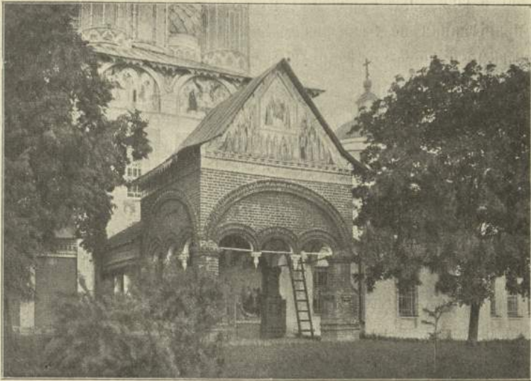
Рис. 117. Нерехта. Крыльцо Владимірской церкви.
